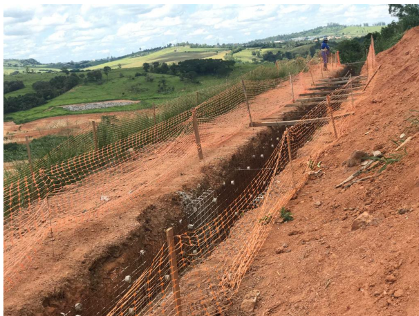
Foto 17: Implantação de Sistema de drenagem. 03/11/2021).
