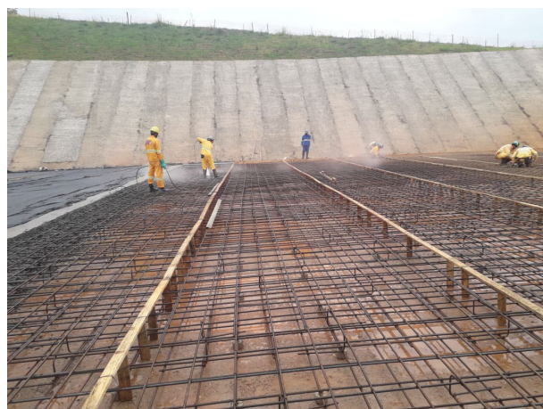
Foto 26: Armação em vertedouro (19/12/2021)
