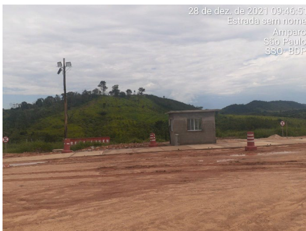
Foto 2: Avanço de instalação de balança rodoviária (28/12/2021)
