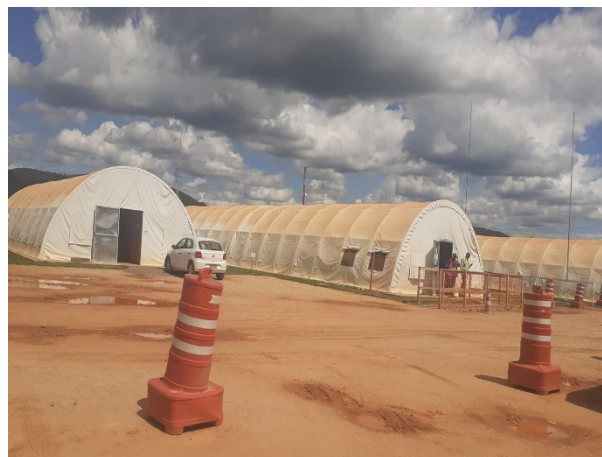
Foto 3: Estruturas no Canteiro Industrial – vista superior (27/11/2021)
