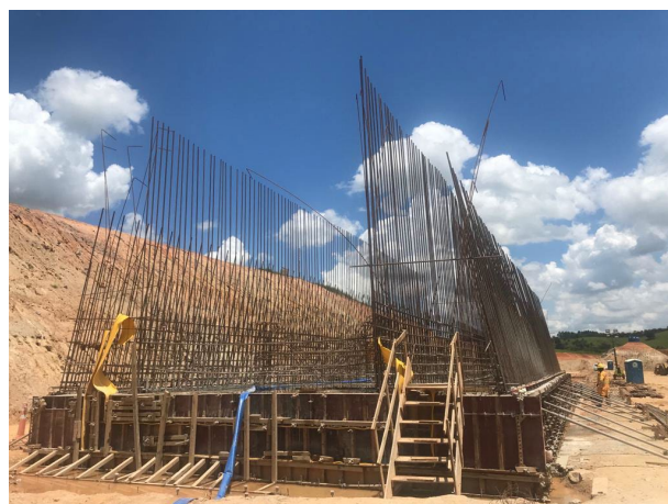
Foto 27: Armação na galeria de desvio (21/01/2021)
