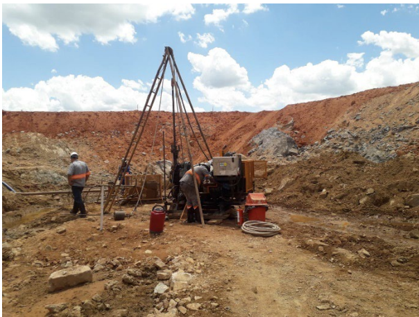
Foto 21: Sondagem no vertedouro da Barragem (Sondosolo - início: 05/11/2021)
