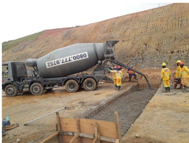
Foto 23: Concretagem na galeria (20/10/2021)
