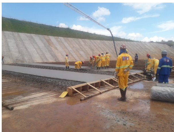
Foto 24: Concretagem na galeria (24/10/2021)
