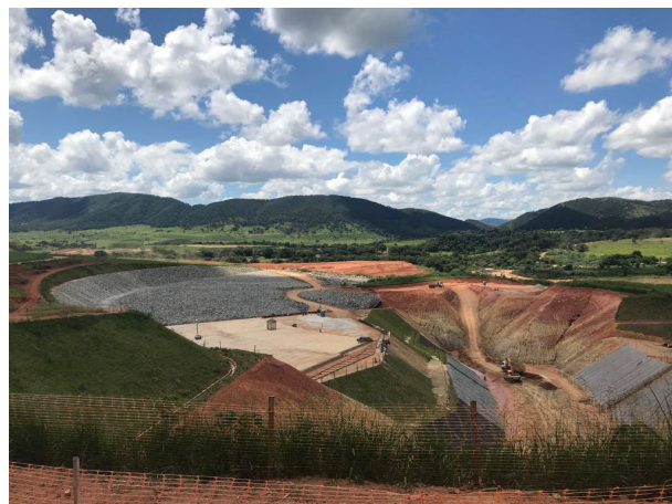
Foto 28: Vista panorâmica da obra BDP (29/01/2022).
