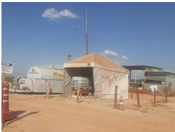
Foto 1: Área de abastecimento de equipamentos (25/11/2021.)
