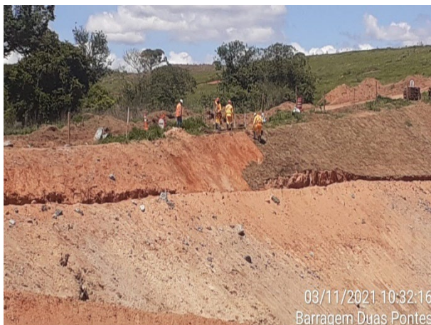
Foto 19: Plantio de Grama em talude de corte (03/11/2021).
