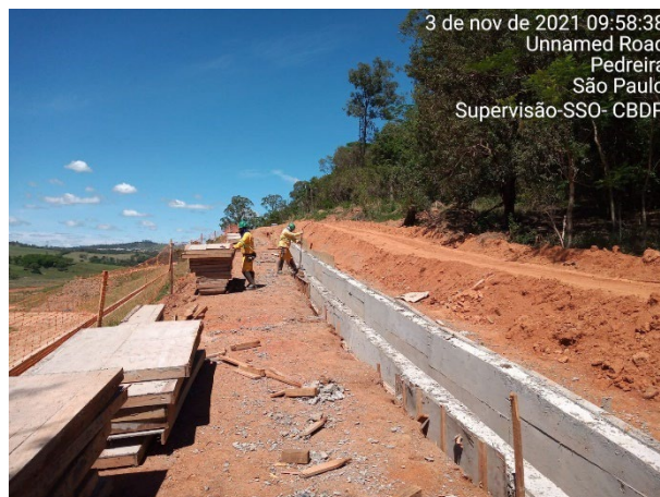
Foto 18: Implantação de Sistema de drenagem. 03/11/2021).
