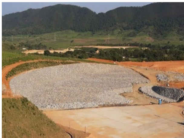
Foto 25: Enrocamento no Canal de Aproximação Vertedouro (05/11/21)
