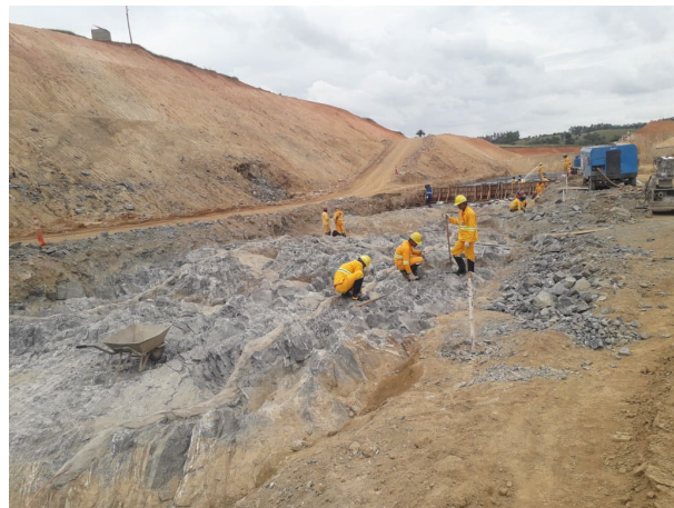
Foto 22: Limpeza rigorosa com jato d'água e ar comprimido no topo rochoso, - Galeria de Adução 22/11/21
